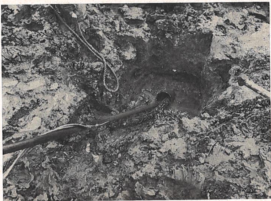
De kabel is vanuit het water door de buis aan land gebracht.
