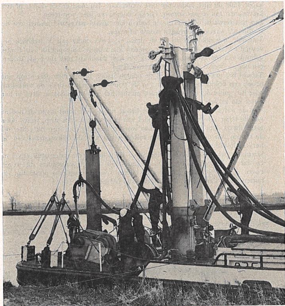
Het spuitstuk staat nog op de ponton. Het aanbrengen van de waterslangen wordt voorbereid.
